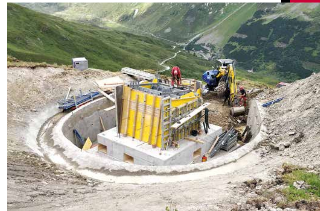
Spezielle geologische Gegebenheiten erfordern durchdachte Baumaßnahmen. Bei den Stützen 13 und 14 wurden, wie Markus Siegele erklärt, Vorkehrungen getroffen, um auf Bewegungen des Untergrundes reagieren zu können.
