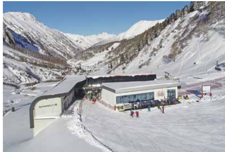
Gemessen am Inhalt zeigt sich die Talstation recht unscheinbar. Dabei sind hier neben dem Sesselbahnhof für 122 Sessel, die Druckluft- und Armaturenstation für die Schneeanlage, die Energieversorgungsstationen der Gampenbahn, der Gampen- und Fimbalpe und der Schneeanlage und das Restaurant mit allen dafür erforderlichen Lagerräumen untergebracht.
