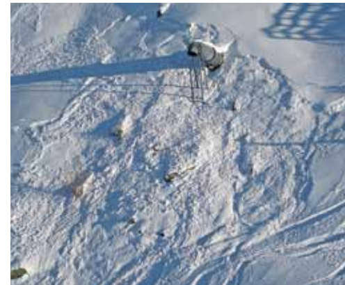
Oben: Schneeprofil • Unten: Sprenganlage-Gaz.EX – wird von der Zentrale aus gesteuert
