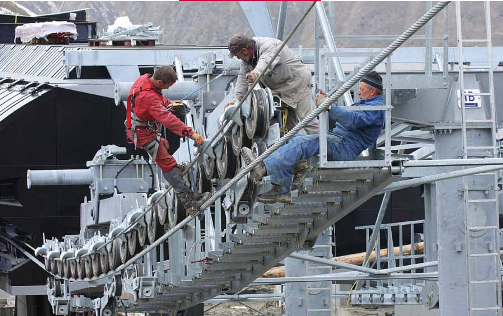
Oben: Einziehen des Förderseiles
