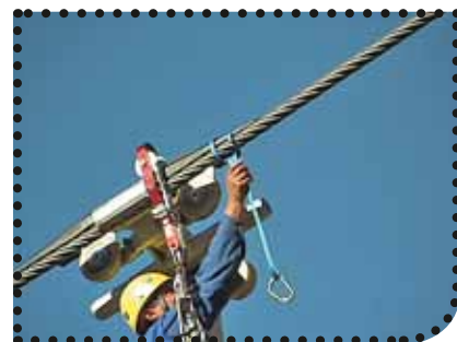
Der Retter hängt eine Rundschlinge mit Karabiner am Seil ein.
