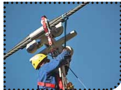
Nun wird am Karabiner das Abseilgerät für den Passagier eingehängt.
