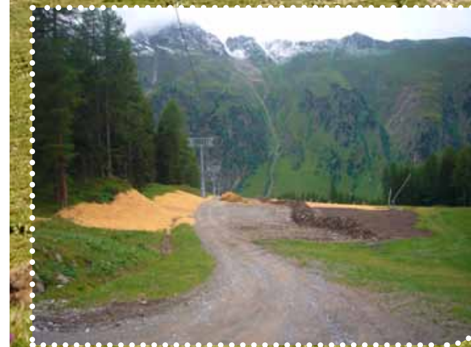
Vorbereitungsarbeiten mit Humus und Stroh
