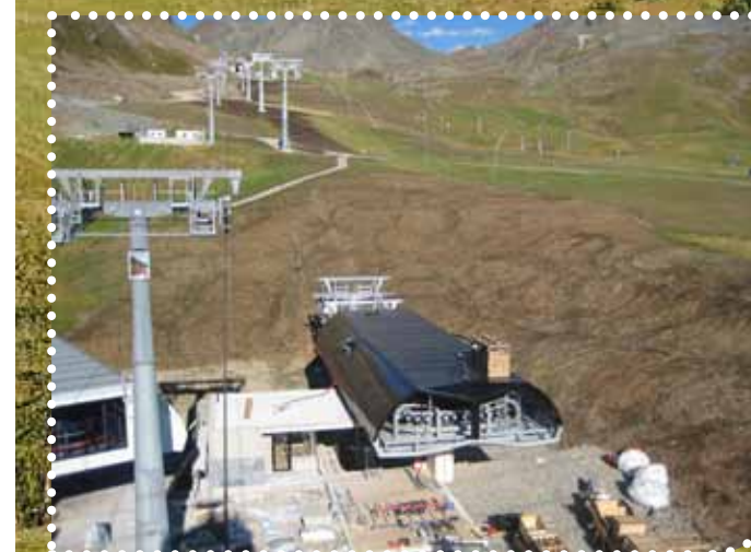
Nach Abschluss der Begrünungsarbeiten – Sonnenbahn
