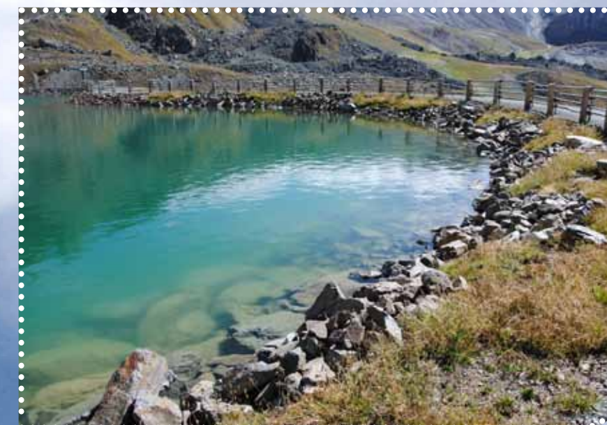
Von oben: Propellerschneeerzeuger, Pumpenstation, Speicherteich Velill-Idalp II Großes Bild: Schneilanze
